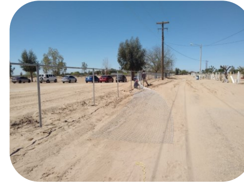
Reparación de cerco perimetral esc. Sec. 120 Ej. Lázaro cárdenas
